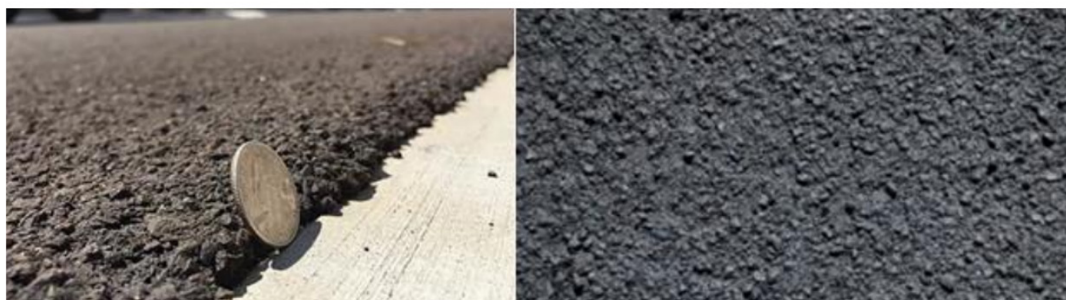
Рис. 2.2 Поверхнева структура вирівняних тонких литих асфальтобетонних (ЛЕМС) покриттів
