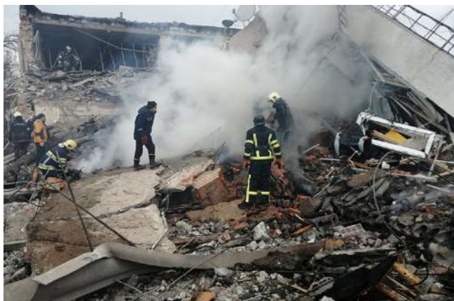
а) знищення інфраструктури аеропорту м. Кривий Ріг
