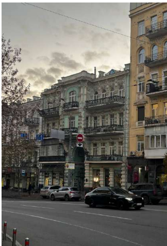
Фото фасаду з видової точки 1
