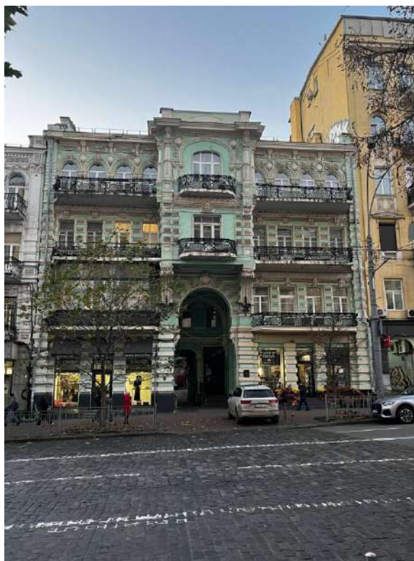
Фото фасаду з видової точки 2
