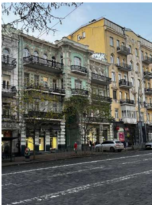
Фото фасаду з видової точки 3
