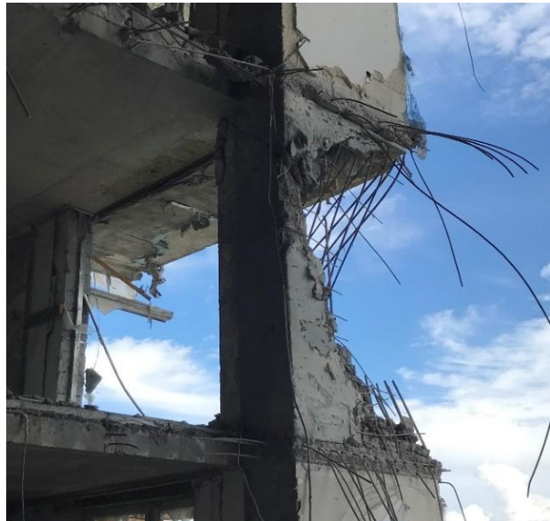
Рисунок 4.4 – Приклад значних (важких) пошкоджень залізобетонних вертикальних конструкцій:
