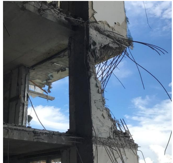
Руйнування частини пілона
