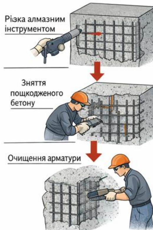
Рисунок А1 - Підготовка пошкодженої поверхні вертикального залізобетонного елемента перед виконанням ремонтно-відновлювальних робіт
