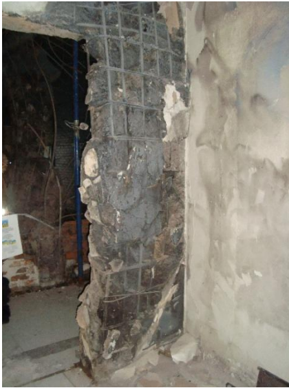
Руйнування частини діафрагми жорсткості
