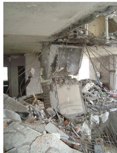
Рисунок 1.9 – Вигин та руйнування пілона
