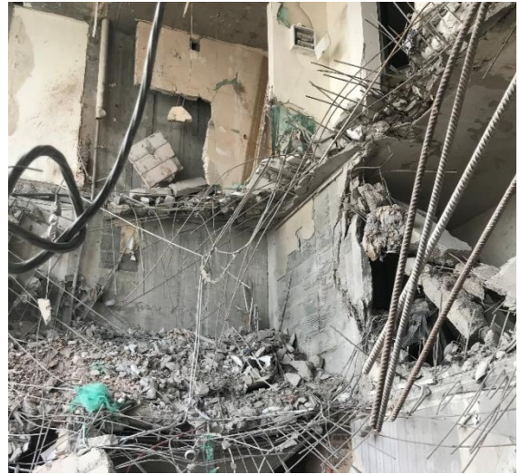
Руйнування частини діафрагми жорсткості
