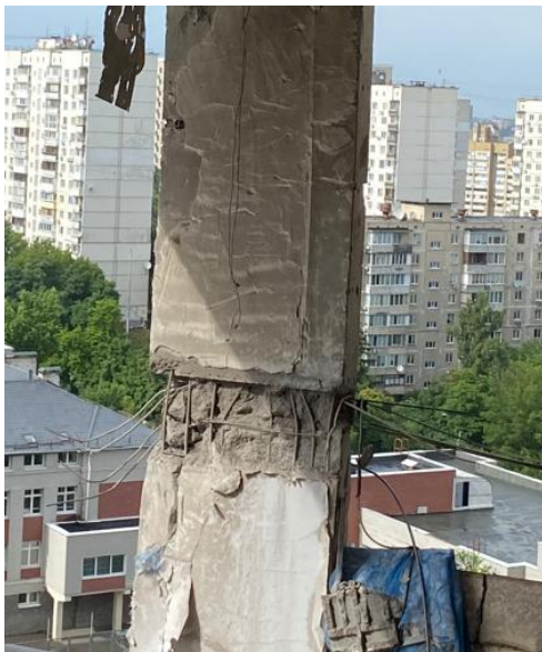
Рисунок 4.4 – Приклад значних (важких) пошкоджень залізобетонних вертикальних конструкцій:
