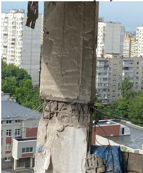
Руйнування в місці примикання плити перекриття до пілона
