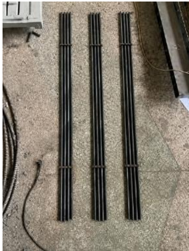
Рисунок 3.3 – Нарізання та в'язання арматурної сітки
