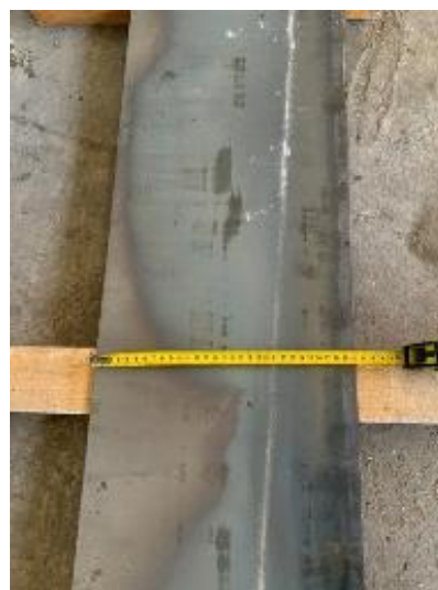
Рисунок 3.2 – Підготовка сталевих листів для формування незнімної опалубки
