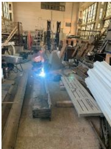
Рисунок 3.5 – Виконання з'єднання листів між собою за допомогою ручного електродугового зварювання
