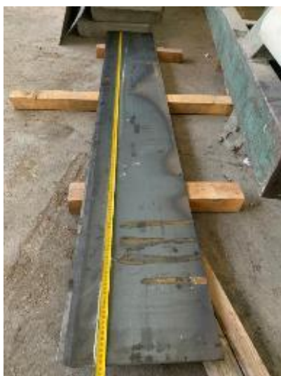
Рисунок 3.2 – Підготовка сталевих листів для формування незнімної опалубки
