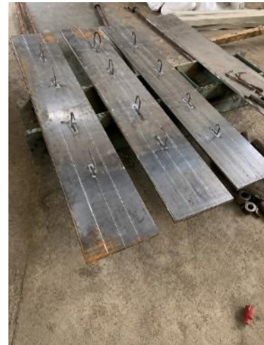
Рисунок 3.4 – Приварювання арматурних стрижнів до нижнього сталевго листа
